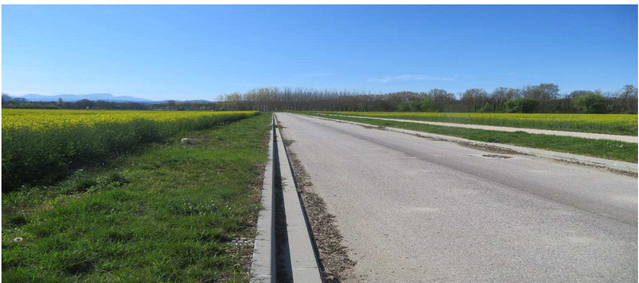
Vue sur la partie centrale de la zone d'étude immédiate occupée par une route construite dans le but de desservir les futures constructions de la ZAC – ECOTER 2021
