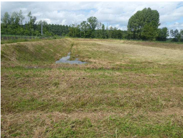
Vue du bassin depuis l'arrivée d'eau principale après une pluie et après entretien Photos prises dans la zone d'étude – ECOTER, 2021
